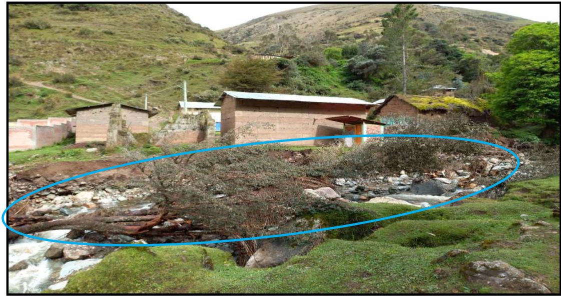
FIGURA N°02: MATERIAL COLMATADO EN EL CAUCE DE LA QUEBRADA JURCA, CON UNA PROFUNDIDAD PROMEDIO DE 1.0 M. ESTO PROVOCA QUE DESBORDAMIENTO DEL RÍO SEA MAS INMINENTE.
