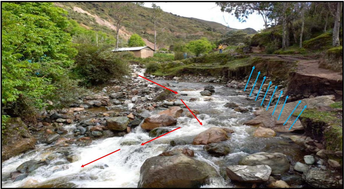
FIGURA N°03: EN LA TEMPORADA DE MAXIMAS AVENIDAS EN LA QUEBRADA SE OBSERVA LA SOCABACIÓN POR LA MARGEN IZQUIERDA EN EL SECTOR SAN ANTONIO DE JURCA, DISTRITO SAN PEDRO DE CHAULAN - HUÁNUCO - HUÁNUCO, CUYO TRAMO SE ENCUENTRA COLMATADO Y DESPROTEGIDO,
